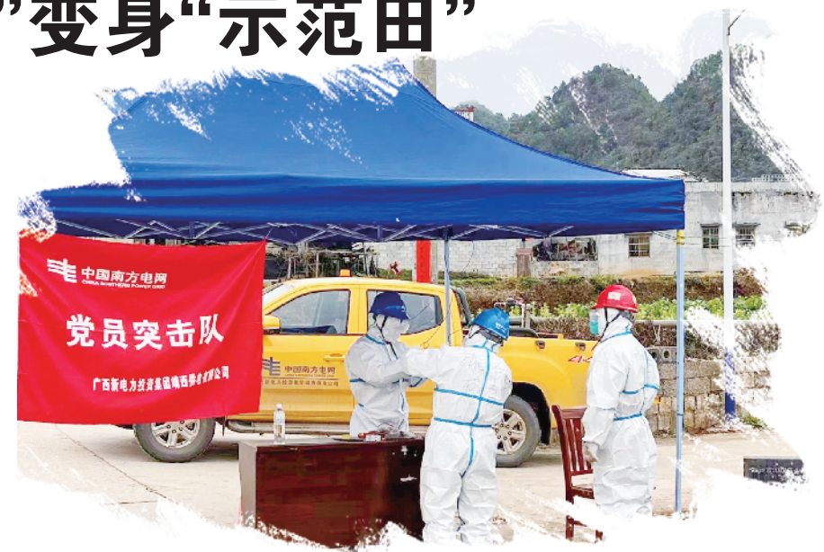
南方电网广西新电力集团靖西供电公司党员服务队为防疫卡点接通电源。梁卡依/摄
