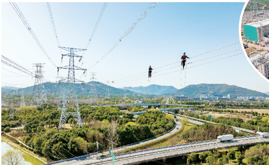
▲白鹤滩-江苏±800 千伏特高压直流工程姑苏换流站鸟瞰图。倪瑞峰/摄 ▼国网苏州供电公司组织工作人员对白鹤滩配套送出迁建工程——500 千伏梅里-木渎线路开展走线验收,及时排查消除隐患。谢鹏/摄
