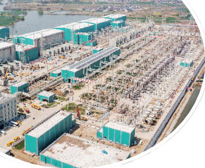
▲白鹤滩-江苏±800 千伏特高压直流工程姑苏换流站鸟瞰图。倪瑞峰/摄 ▼国网苏州供电公司组织工作人员对白鹤滩配套送出迁建工程——500 千伏梅里-木渎线路开展走线验收,及时排查消除隐患。谢鹏/摄
