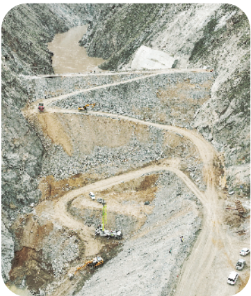
图为羊曲工程施工局上游围堰填筑时的场景 路遥/摄
