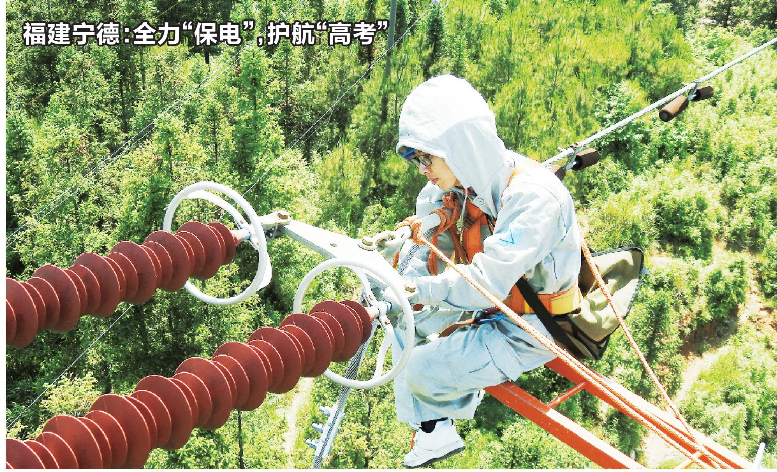
6月6日，福建宁德供电公司输电运维班人员在周宁县110kV科东线25号塔处处理C相耐张线夹发热缺陷，确保高考保电线路安全可靠运行。
