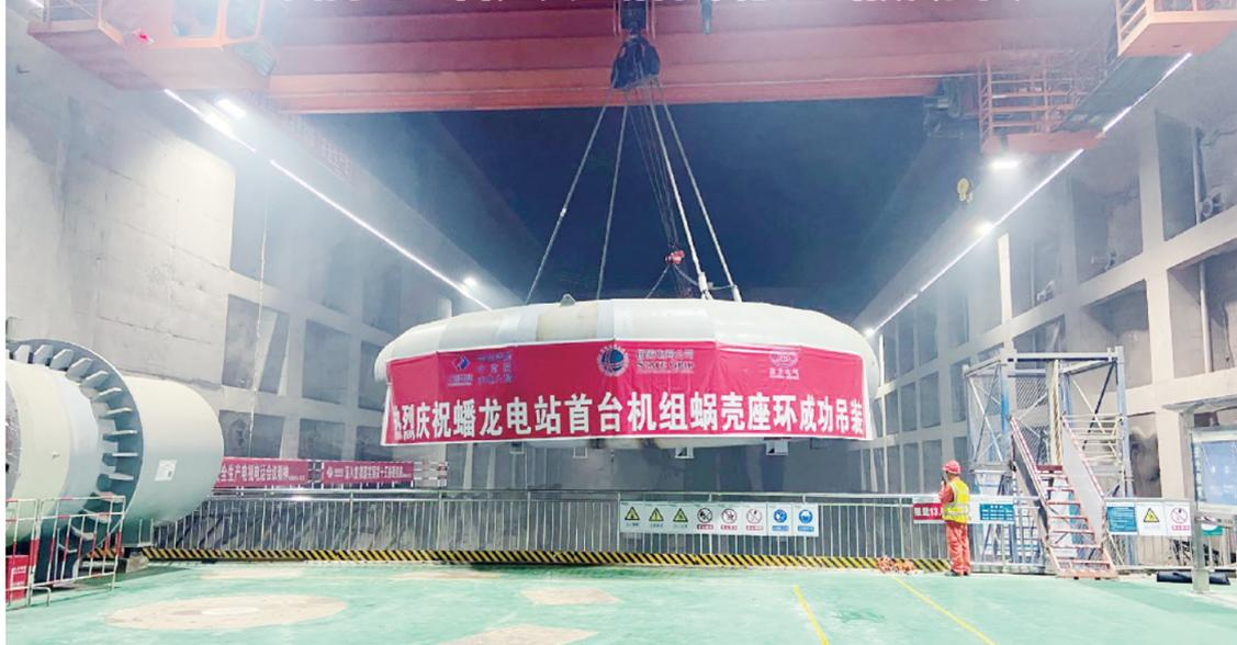
近日,西南地区首座大型抽水蓄能电站——重庆蟠龙抽水蓄能电站,成功完成首台机组蜗壳座环吊装,标志着蟠龙抽水蓄能电站机电安装正式进入高峰期。该电站由4台30万千瓦的可逆式水泵水轮机组组成,总装机容量120万千瓦,设计年抽水电量26.72亿千瓦时,年发电量20.04亿千瓦时。图为吊装现场。
