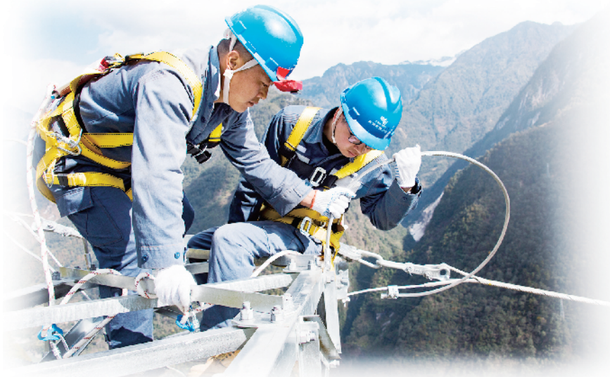
2020年12月18日，独龙江乡35千伏联网工程子项即将完工，云送项目部质检人员登塔开展三级自检工作。张强/摄
