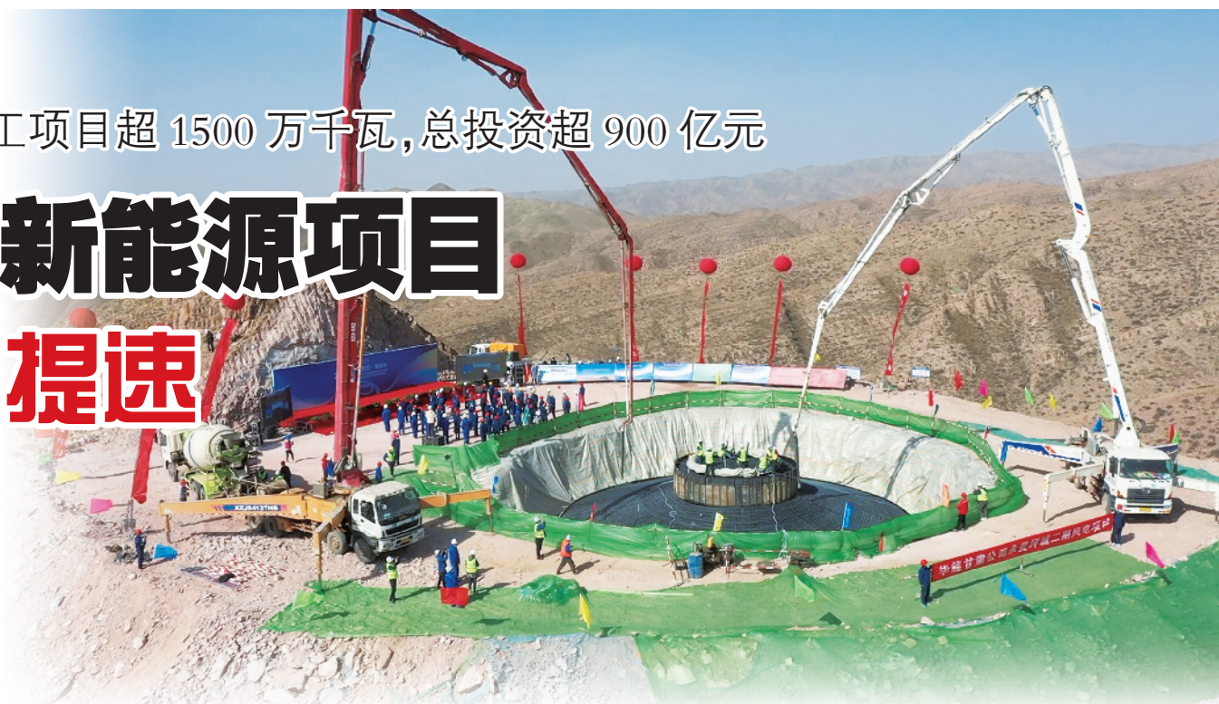
中国华能甘肃永登坪城二期风电项目开工
