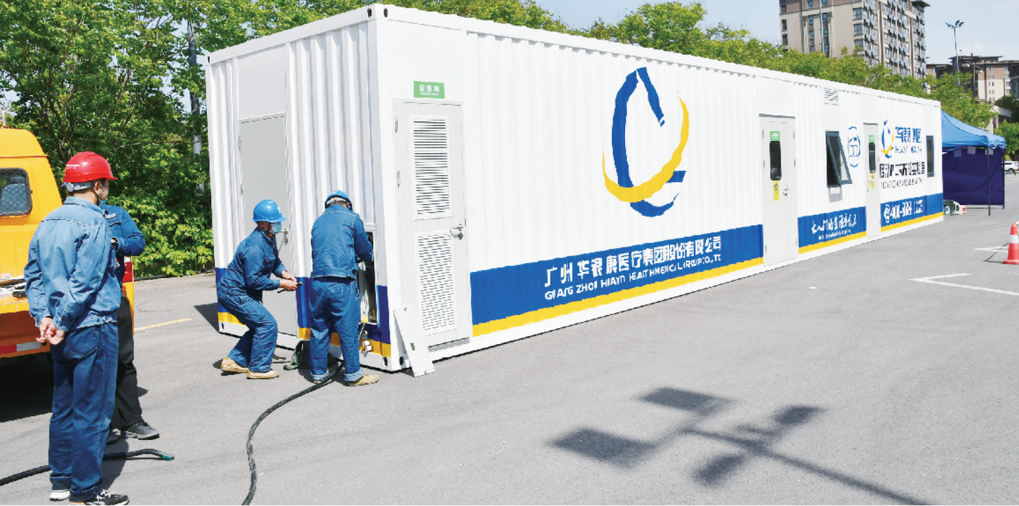
4月18日中午12时,国网陕西西安临潼供电公司接到防疫指挥部为新建“方舱核酸检测室”接电的通知后,闻令而动,快速出击,经过3个小时的施工,敷设电缆29米,制作电缆头2个,实验室顺利供电。 潘世策/摄
