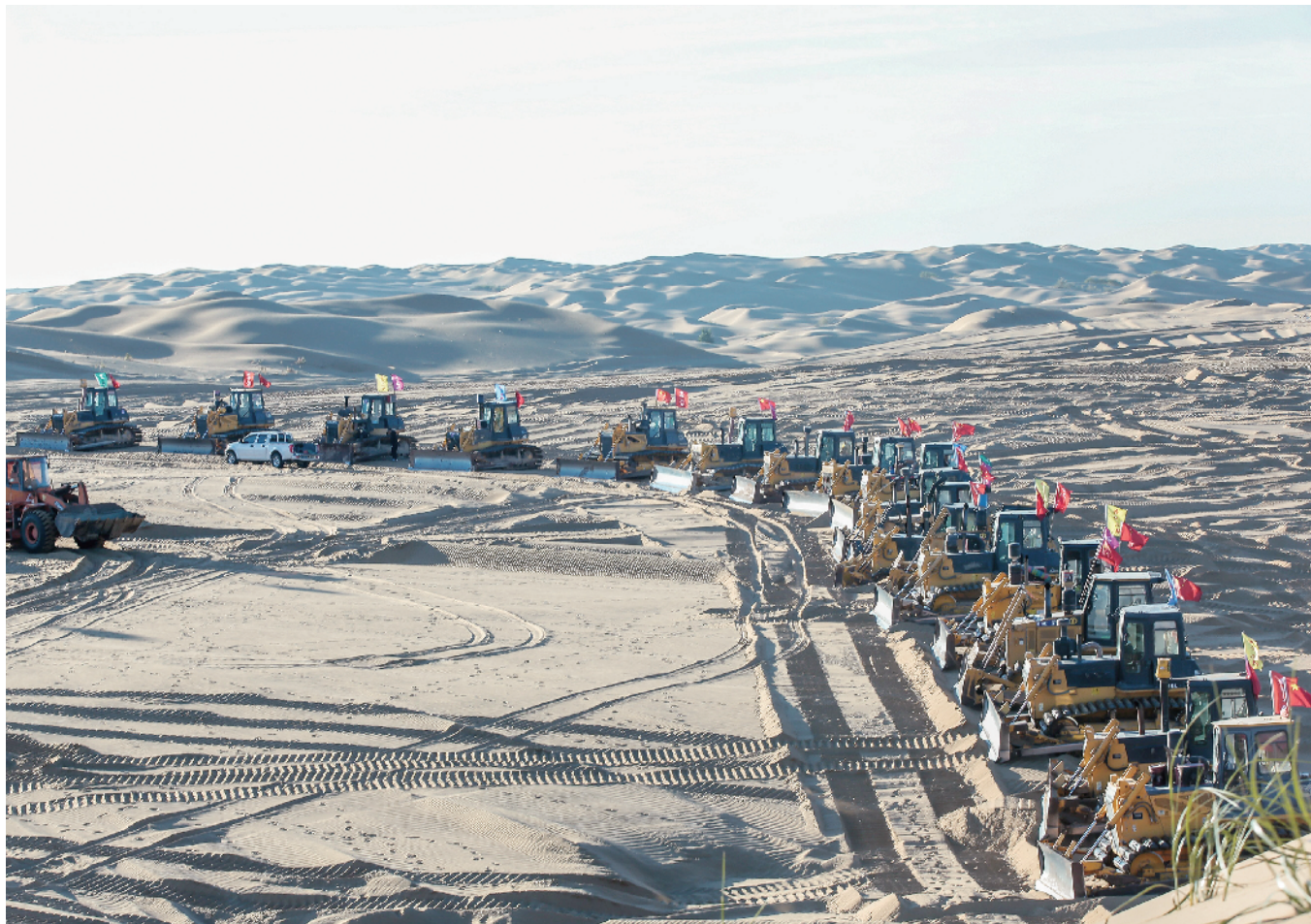
2021 年 10 月 16 日,内蒙古西基地库布其 200 万千瓦光伏治沙项目开工现场。
