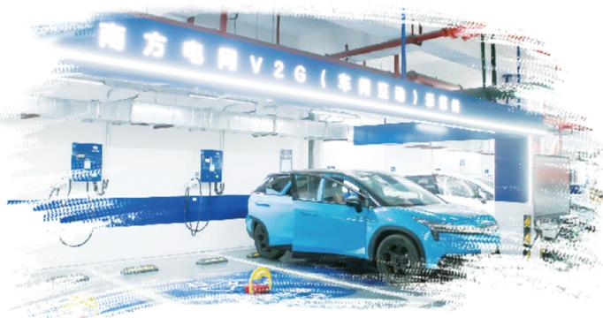
本报讯 近日,在广东省深圳市龙华区民兴苑小区,一辆新能源小轿车停靠在智能充电桩前,只见司机下车将充电线插进汽车,充电屏幕显示“汽车返送电成功”。据了解,这是南方电网公司在深圳投运的粤港澳大湾区首个车网双向互动(V2G)示范
