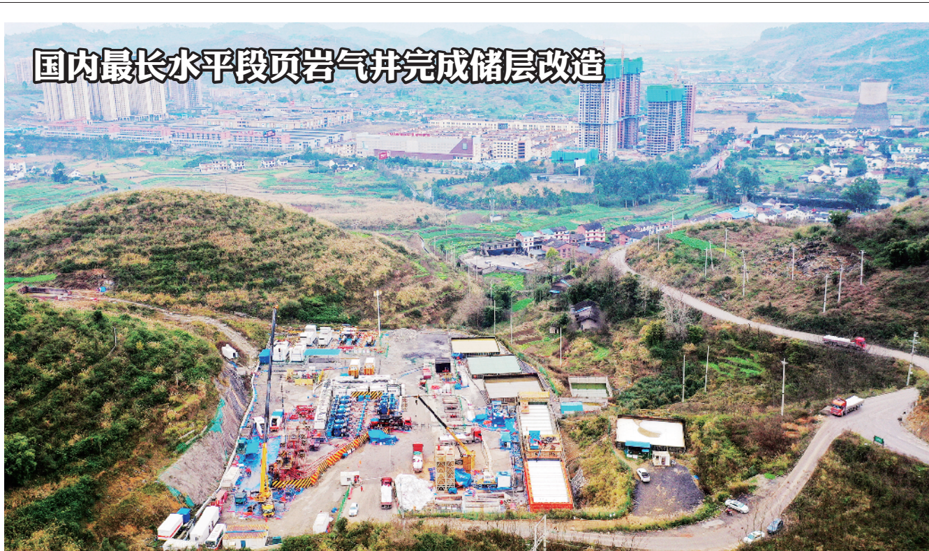
1月15日,历时14天,位于重庆南川的中国石化华东石油局顺利完成新年第一口页岩气井胜页9-6HF井全井46段储层改造施工,该井水平段长3601米,打破了2021年胜页9-2HF井创造的3583米国内页岩气井水平段长最高纪录。
