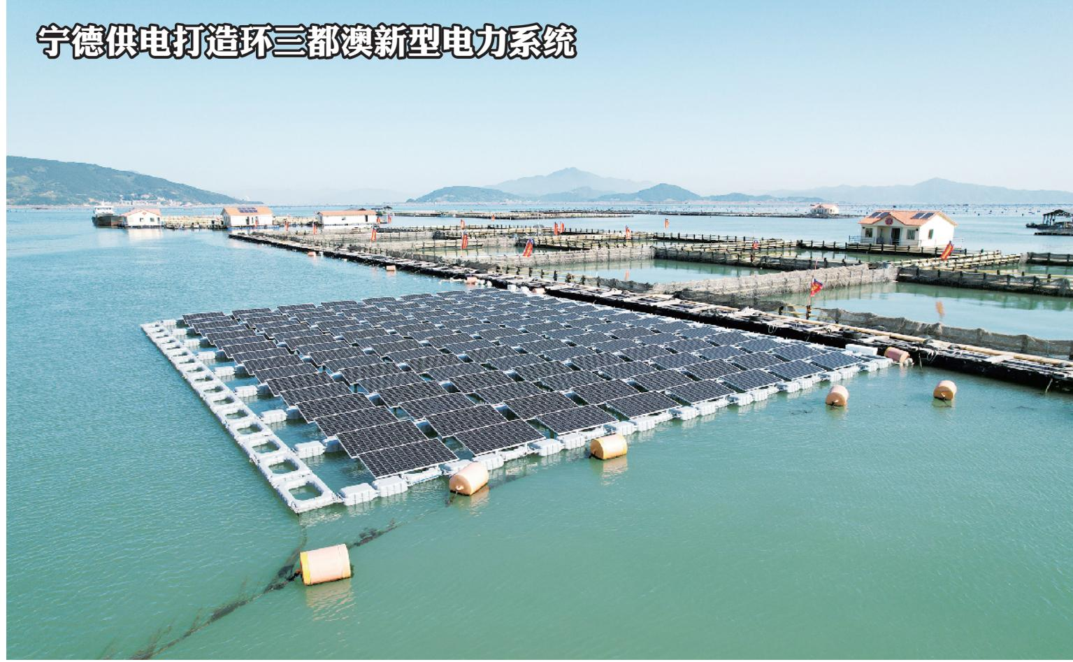
近日,在福建宁德三都澳白基湾深水网箱养殖基地,福建省第一个海上漂浮式光伏项目正式完工投运。该项目是国网宁德供电公司全力打造环三都澳新型电力系统,在原有海上风光储一体化项目基础上的探索实践,项目配套100千瓦储能系统、200千瓦时电动船泊充电桩系统等,旨在实现海上渔排生产用能的“油改电”替代。雷美容/摄
