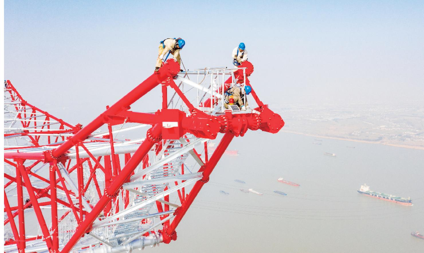
1月12日,江苏无锡高达385米的凤城至梅里500千伏长江大跨越工程输电铁塔封顶,刷新世界第一输电铁塔高度的纪录。
