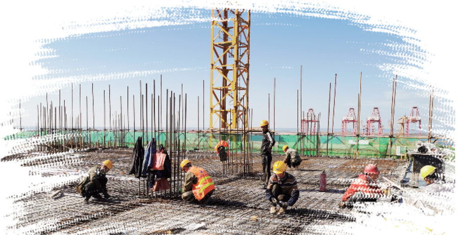
图为太平湾合作创新区项目施工现场
