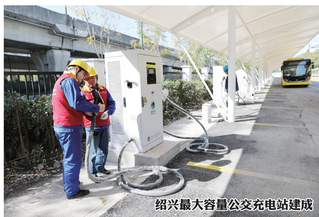
11月20日,浙江省绍兴市柯桥区湖光桥公交站8座充电桩箱变投运,标志着该市容量最大的公交充电站建成。据了解,湖光桥充电站8座箱变总容量达5040千伏安,站内共装有28套一机双枪式直流充电桩,拥有56支快充充电桩,可满足56辆电动汽车同时充电需求。充电功率最高可达120千瓦,家用电动汽车在快充模式下充电30分钟,就可上路行驶400公里。 许倩汝/摄
