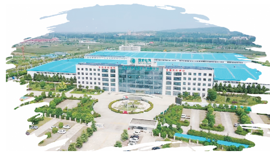
河南平高通用电气厂区全景图
