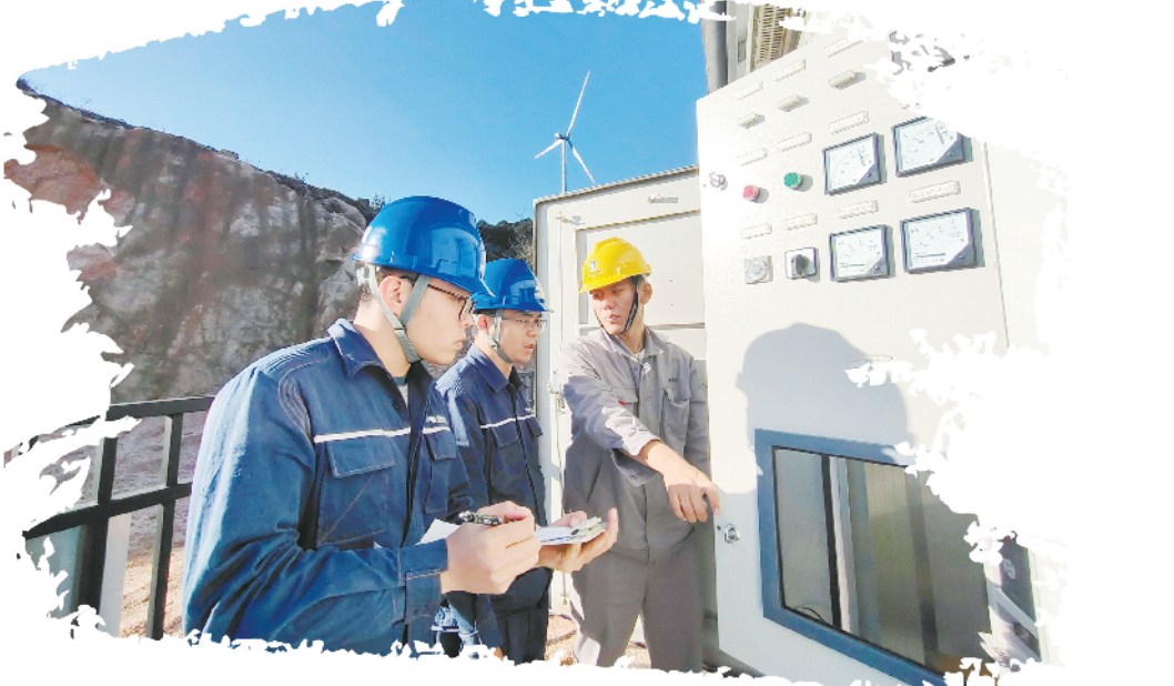
11月9日,南方电网广西贺州供电局工作人员协同风电场对其发电上网线路进行隐患排查。黄玉萍/摄
