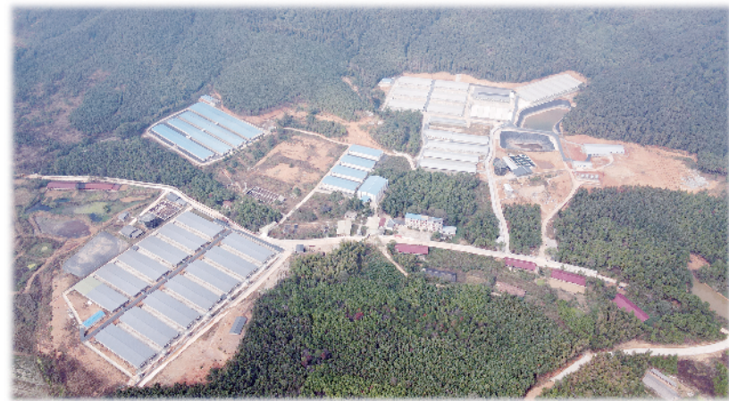
正在建设的江西新干县综合能源示范利用点。孙隽源/摄
