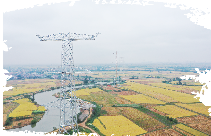
南长线特高压铁塔正在组立。周洁雯/摄
