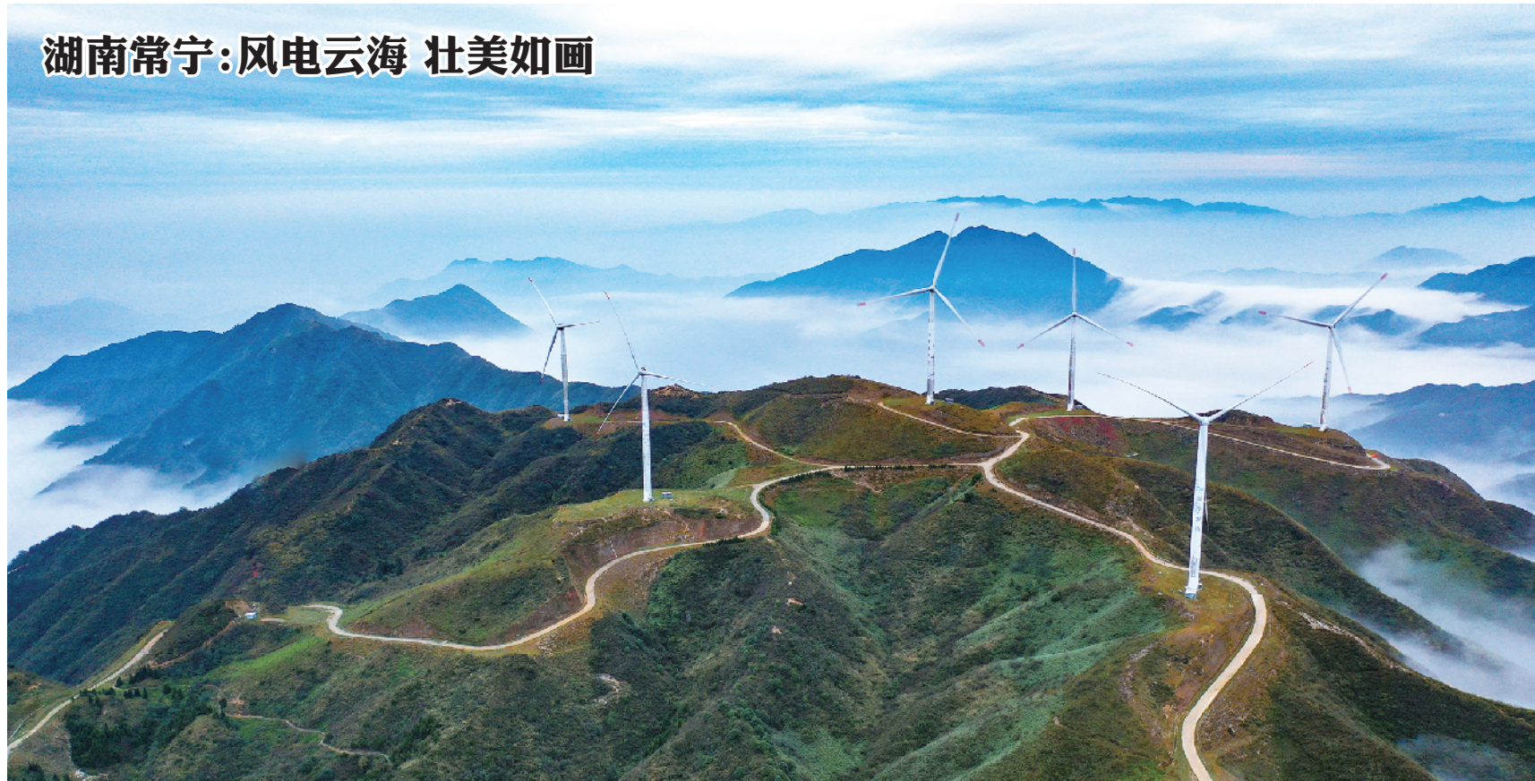
湖南省衡阳市常宁市与郴州市桂阳县交界处的天堂山上,风力发电机在云海间若隐若现,美不胜收。天堂山风电场一期工程装机容量为4.99万千瓦,设计安装25台风力发电机组,年上网电量约为11086万千瓦时。
