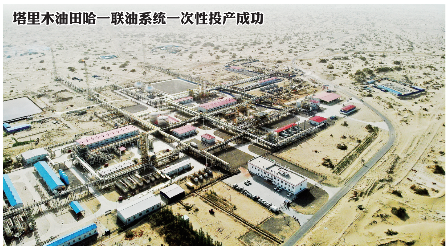
日前,塔里木油田哈得逊油田玉科区块开发地面工程哈一联油系统一次性投产成功。塔里木油田油气田产能建设事业部在该系统建设期间,持续强化安全和质量管控,助力塔里木油田进一步释放产能,提升油气生产能力。图为10月12日,扩建中的塔里木油田哈一联合站鸟瞰图。 谭辉 徐继威/图文
