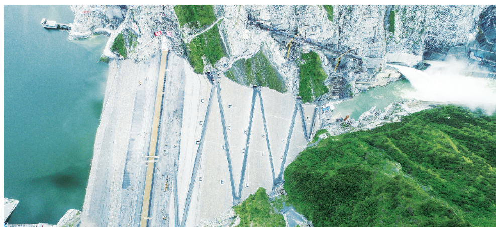
两河口水电站大坝鸟瞰
