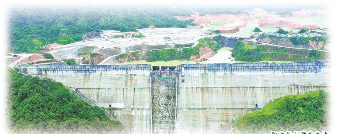
阳江抽水蓄能电站
