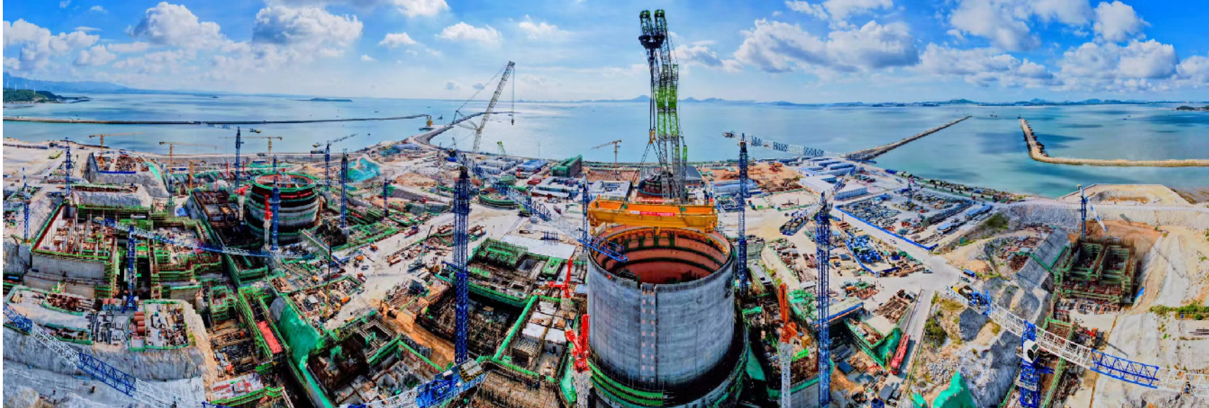
8月24日，漳州核电1号机组环吊桥架整体吊装就位，这是华龙一号核电机组首次实现环吊整体吊装，为机组主设备施工提前释放了工作面，也为后续主设备引入及内穹顶吊装打下基础。此次吊装中，中国核工业二三建设公司运用全新安装工艺，简化分段吊装繁琐的拆分及组装过程，显著提高了施工效率。图为吊装现场。
