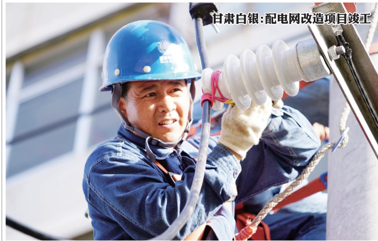
为解决白银城区及5个县区部分区域配电网架结构薄弱、配电网线路分段少、停电影响范围大等问题,2020年12月起,国网白银供电公司投资3.94亿元,实施2020年调增配电网工程项目,工程于2021年7月底竣工。图为2021年6月,施工人员在2020年调增配电网工程白银市水川路10千伏新建线路工程中绑扎导线。
