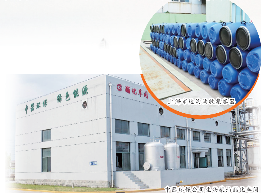
中器环保公司生物柴油酯化车间
