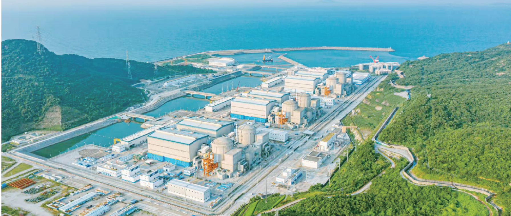
7月28日,中国核能行业协会发布全国核电运行情况。今年1-6月,全国运行核电机组累计发电量为1950.91亿千瓦时,比2020年同期上升了13.76%,占全国累计发电量的5.04%。与燃煤发电相比,核能发电相当于减少燃烧标准煤5517.17万吨、减少排放二氧化碳14454.98万吨。图为阳江核电基地。
