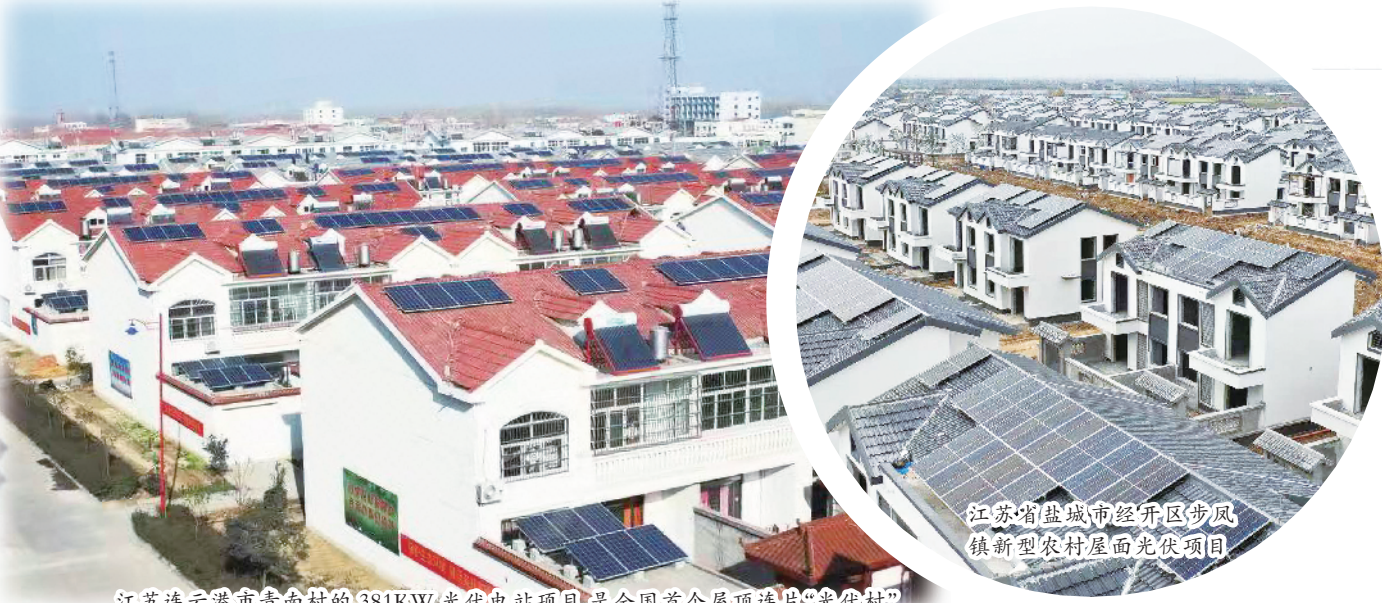
江苏连云港市青南村的381KW光伏电站项目,是全国首个屋顶连片“光伏村”
