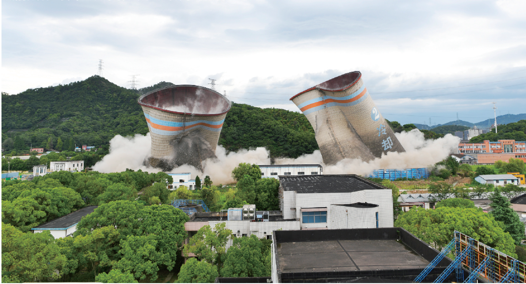
近日,浙能集团萧山发电厂两座服役20多年的冷却塔应声崩塌,90米高的巨型建筑物顺利爆破拆除。两座冷却塔是萧山发电厂一期两台12.5万千瓦国产燃煤机组的配套设备,两台机组自投产发电到关停期间,累计发电量347.45亿千瓦时,供热103万吨。图为爆破现场。朱将云 黄胡光/图文
