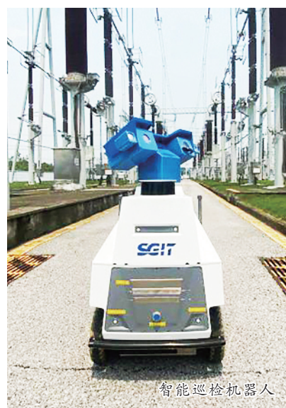
智能巡检机器人
