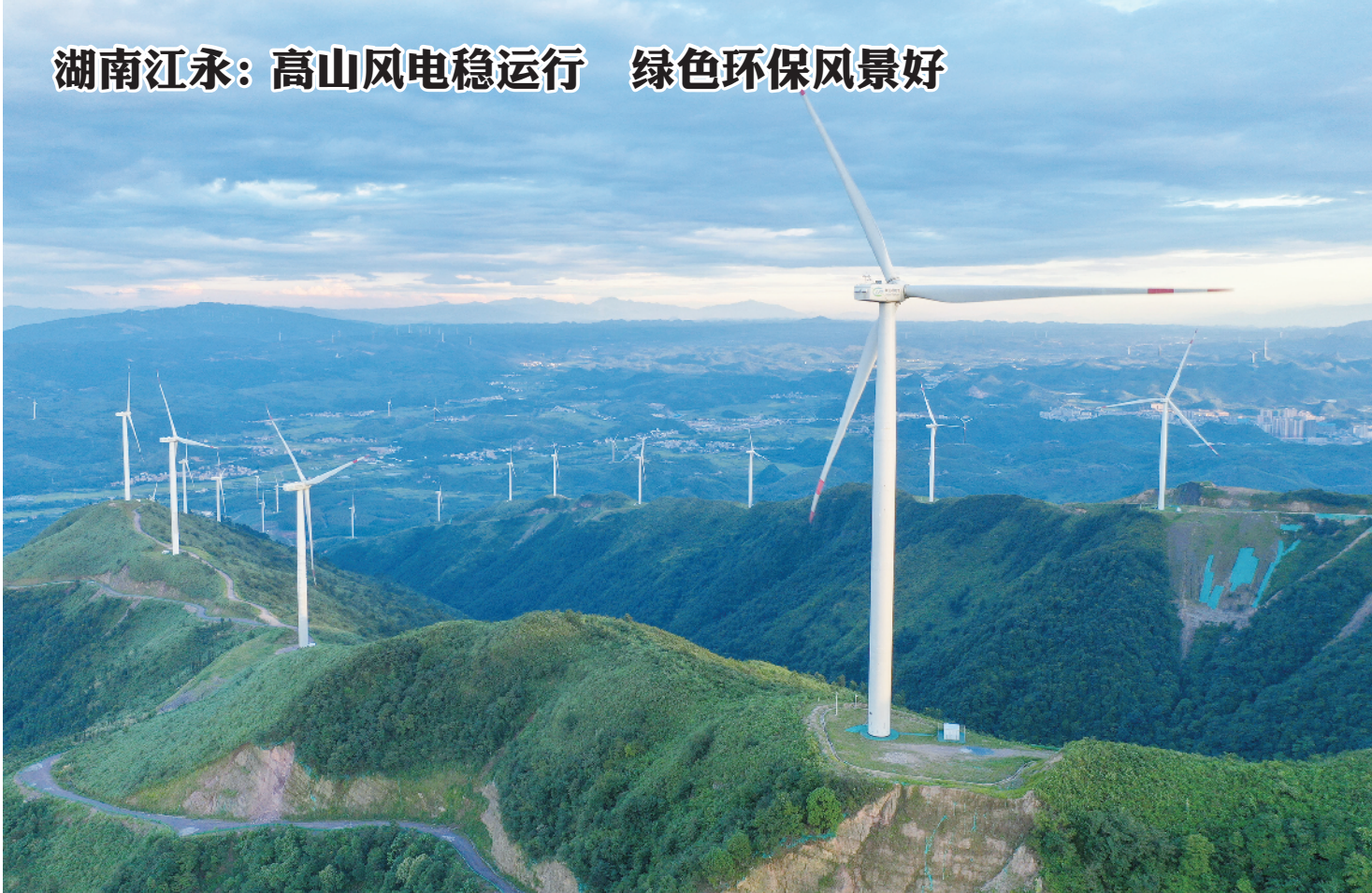
7月8日,位于湖南省永州市江永县的飞龙风力发电机组正在运行中。近年来,江永县坚持高质量绿色发展理念,推进高山风能、光伏发电等绿色经济产业发展,实现生态保护和可持续发展。 人民日报
