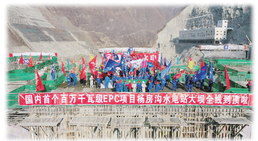
2020年12月17日,杨房沟水电站大坝全线浇筑到顶。
