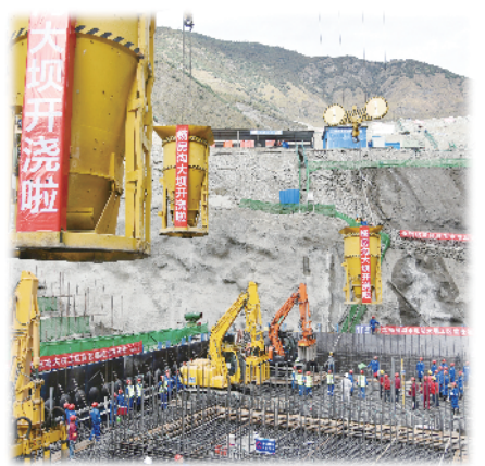
2018年10月30日,杨房沟水电站大坝首仓混凝土开始浇筑。
