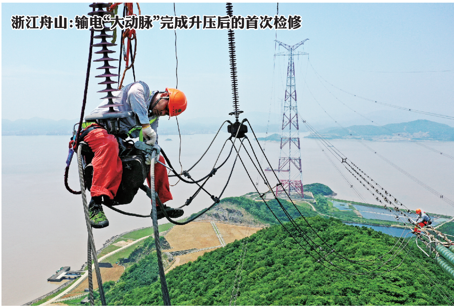
5月31日,海岛输电“大动脉”——舟山500千伏联网输电工程第一通道洛洛线顺利完成升压后的首次检修。图为国网舟山供电公司员工对线路进行集中检修消缺,进一步提升舟山群岛电网安全运行。张帆/摄
