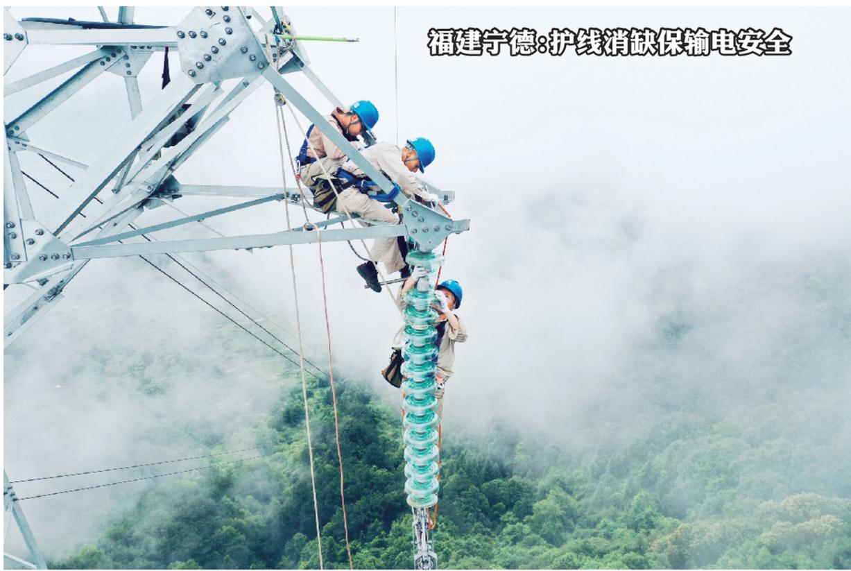
5月下旬以来,福建宁德降雨增多,为了保障输电线路安全稳定运行,国网宁德供电公司在全市重要输电线路进行特护,展开线路巡视消缺工作。图为5月26日,公司员工对宁德市屏南县主要输电线路之一的220千伏清宁线进行绝缘子串自爆瓶等缺陷进行整改修复。游晓辉/摄
