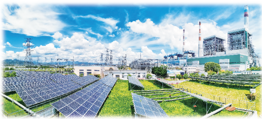
浙能温州发电公司外景。洪伟/摄
