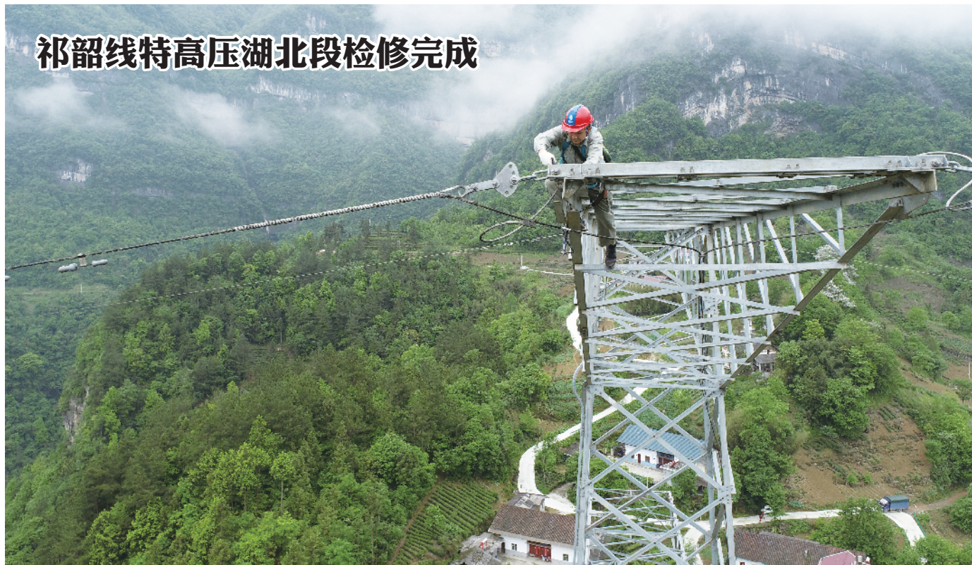
±800 千伏祁韶线是一条“西电东送”特高压直流线路。经过 10 天奋战,日前,湖北段检修顺利完成。图为 5 月 8 日,国网湖北电力检修公司宜昌运维分部输电运维人员在±800 千伏祁韶线上开展线路检修作业。程俊翔/摄
