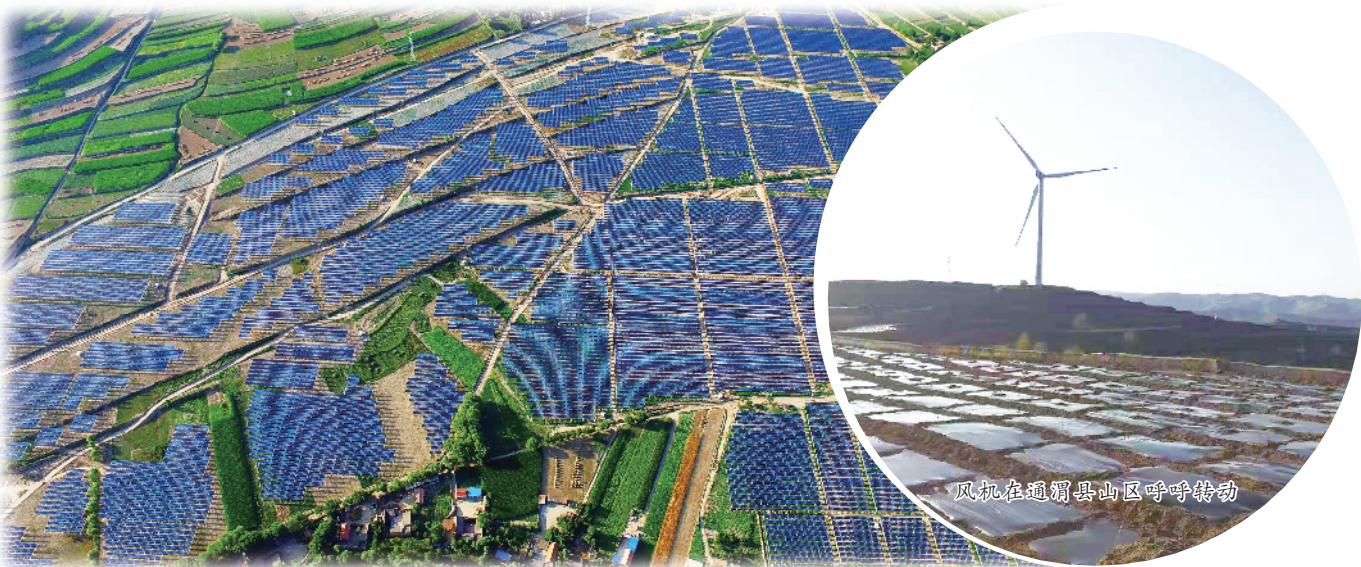
通渭县榜罗镇四新村集中式光伏电站
