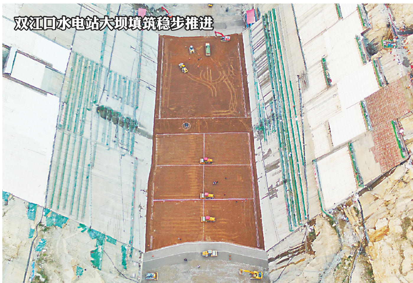
大渡河双江口水电站拦河大坝采用砾石土心墙堆石坝,坝高315米,为世界第一高坝,总填筑量4400万方。电站正常蓄水位高程2500米,总库容28.97亿立方米,总装机容量200万千瓦,计划于2024年首台机组发电。 双江口分公司/图文
