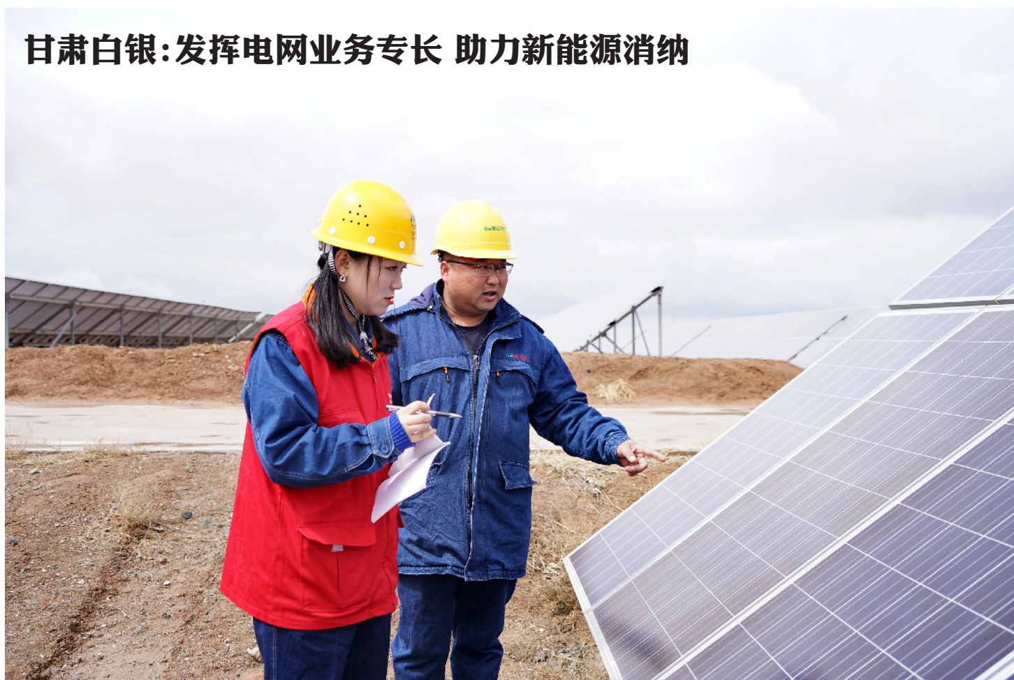
白银电网新能源装机容量达1086.326兆瓦,占白银电网统调装机容量容量的18.9%,新能源比重相对较大。为持续做好新能源消纳工作,4月19日,国网白银供电公司电力调度中心组织8名专业技术人员到靖远德祐光伏电站开展业务服务工作,详细了解电站新能源设备运行情况,现场解决问题。 张红平/摄
