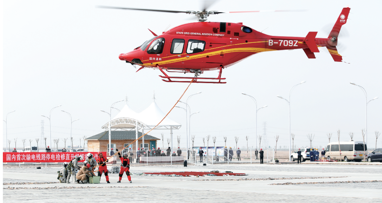
4月9日,国网河北电力联合国网通航公司在500千伏东平一线开展国内首次停电检修直升机规模化作业。图为工作人员正在往直升机上挂装检修组件。 马千里/摄
