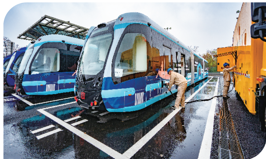
苏州供电公司人员利用车载式模块化移动充电站为吴江 T1 智能轨道列车提供动力电池充电。 谢鹏/摄
