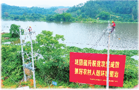
国网江西会昌县供电公司共产党员服务队在该县晓龙乡晓龙村开展电网升级。 邹晓波/摄
