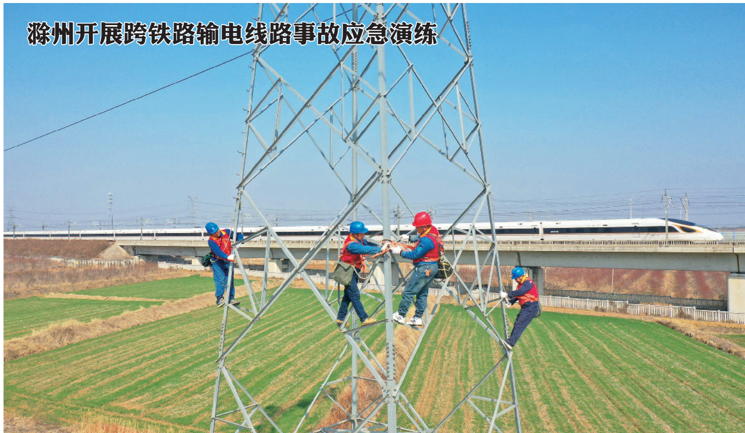
近日,国网安徽滁州市供电公司在定远县青岗村境内开展了跨铁路输电线路断线事故应急演练,模拟跨京沪高铁输电线路故障断线。演练旨在磨合电力应急抢修队伍,提高处置跨铁路输电线路故障应急抢修能力,确保输电设备安全稳定运行。图为电力人员在40多米高空检查输电铁塔和线路。宋卫星/摄
