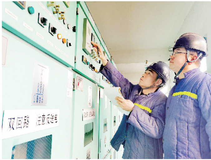
2月11日,中煤新集二矿供电部门职工对供电线路、机电设备进行精细化检修,确保矿区供电安全。
