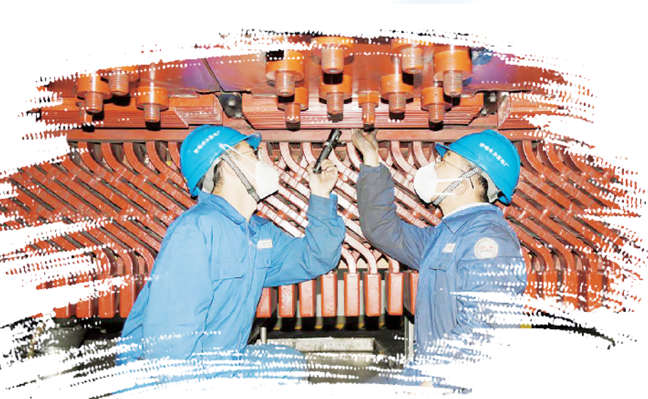
工作人员春节期间在雅砻江官地水电站设备检修
