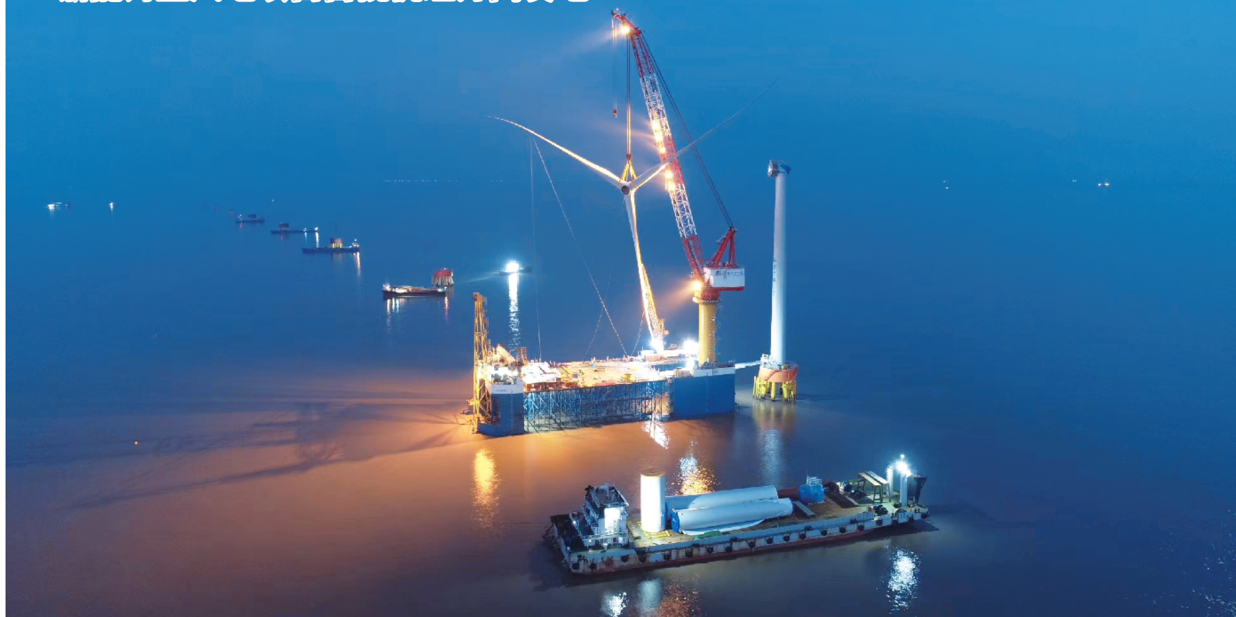
日前,浙能嘉兴1号海上风电场首批采用的湘电风能XE148-4000型海上永磁直驱型风力发电机组成功并网发电。该海上风电场项目位于杭州湾平湖海域,离平湖市约16海里,是浙江省能源发展“十三五”规划建设的重点工程。 湘电风能/供图
