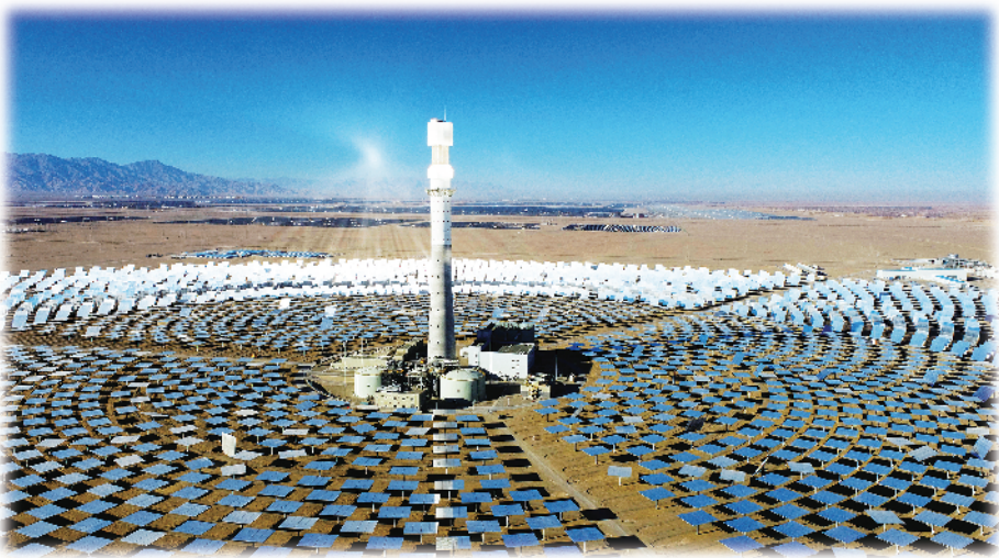
青海格尔木光伏电站。 王国栋/摄
