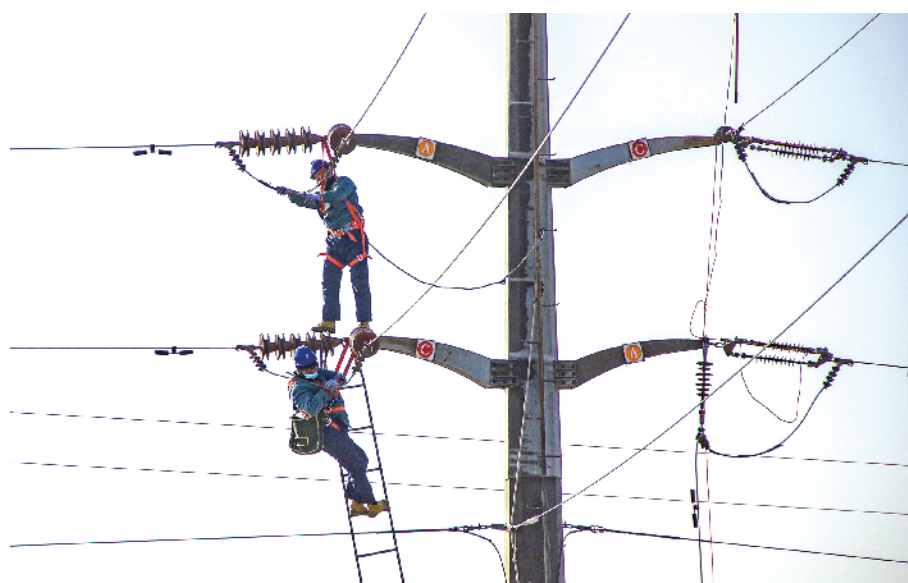
1月26日，国网山东莱州市供电公司人员在程郭镇花楼岭村进行35千伏变电站35千伏塔T接至新建35千伏坊曲线50塔导线连接作业，增强供电能力。 林颂斐/摄
