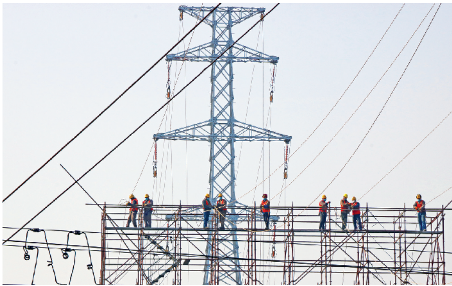
国网山东高城市供电公司人员近日在110千伏创新园工程现场开展电力施工,该工程跨越京沪电气化铁路及省道S101,将完善当地110千伏电网结构。 韩景茹/摄
