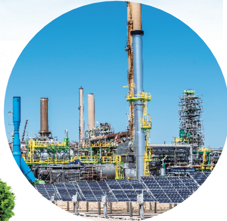
安装了太阳能电站和电解槽的La Mède生物燃料工厂。
