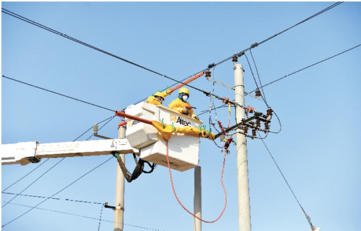
11月11日,国网山东平原供电公司带电作业班人员对10千伏恩槐线北关支线进行带电消缺,保障沿线居民与企业迎峰度冬期间可靠用电。张峰/摄
